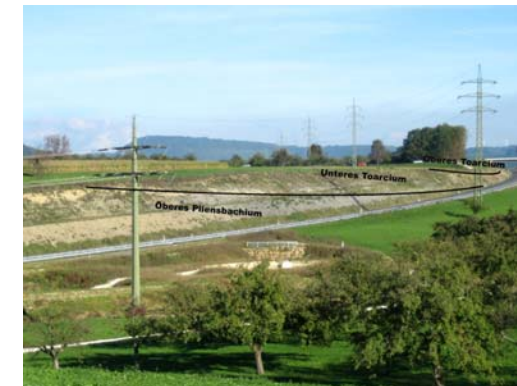
Die nördliche Böschung der B 10 während der Bauphase 2003. Gut zu erkennen ist der fast ebene Schichtverlauf der Juragesteine.
